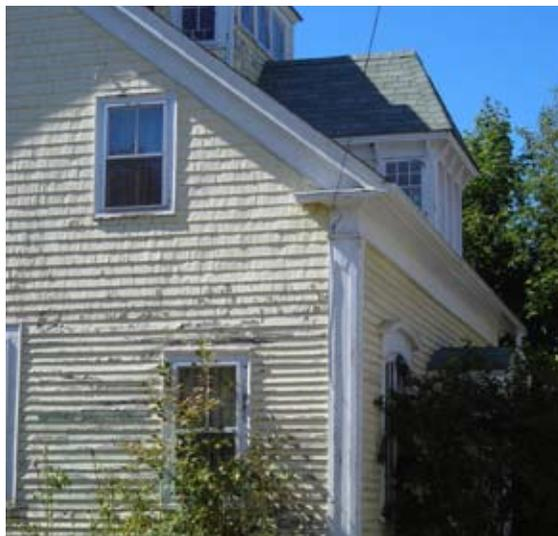
Le bardage est habituellement utilisé pour recouvrir des murs verticaux (ou presque verticaux). Il a d'habitude pour fonction de protéger le bâtiment des intempéries, mais il peut aussi être décoratif.
