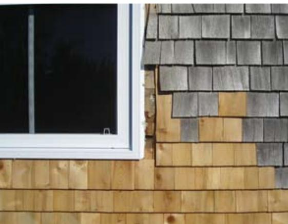
Comme il est fait de plus petites pièces, le revêtement en bardeaux est très facile à modifier et réparer. Dans cet exemple, un mur en bardeaux a été refait autour d'une nouvelle fenêtre, malheureusement en vinyle.
