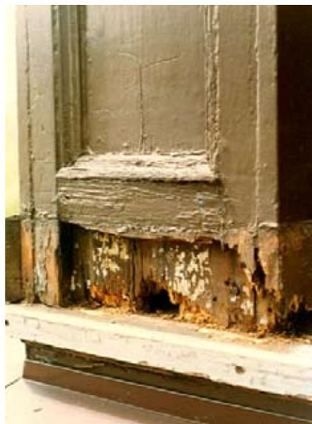
Un revêtement imperméable en métal, combiné à des joints défailants, a entretenu le processus de décomposition à l'abri des regards.
