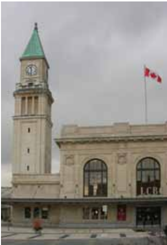
L'ancienne gare ferroviaire à Toronto-Nord restaurée et convertie en succursale de la LCBO.
