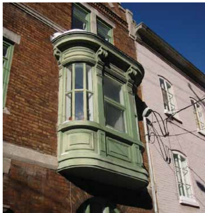
La corniche en porte-à-faux aide à protéger cette fenêtre en baie décorative des entrées d'eau.
