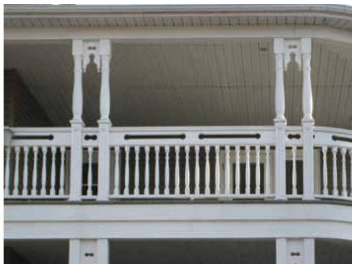
Un garde-corps bien conçu, où les barotins s'assemblent sous la main courante.
