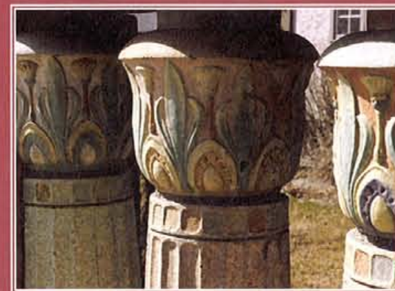
Les balustrades du pont de la rue Albert, à Regina (1930) sont faites de terracotta recouverte de polychrome avec motifs égyptiens.
