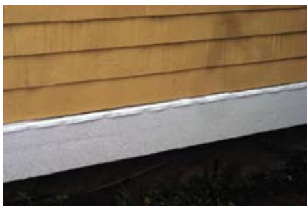
Un nouveau larmier et un nouveau solin sont installés à la base du parement.
