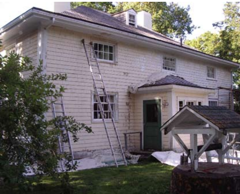
On se prépare à décaper et à repeindre les bardeaux des murs latéraux et arrière.
