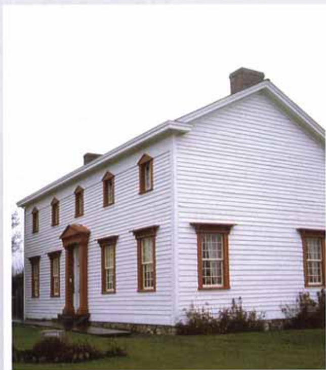
Maintaining the original windows of this historic house on Vancouver Island, B.C., preserves the texture and character. / Le fait de conserver les fenêtres d'origine de cette maison historique sur l'île de Vancouver (Colombie-Britannique) préserve la texture et le caractère.
