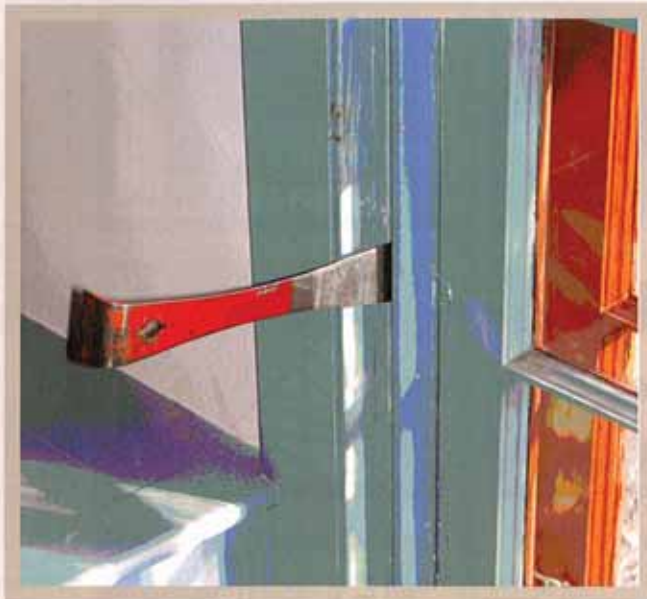
Figure 2 Use a small, sharp pry bar to break the paint film—usually tapping it with the palm of your hand is sufficient force—making sure it is totally free before beginning to pry. / Utiliser un petit levier affûté pour briser le film de peinture. Il suffit habituellement de le taper légèrement avec la paume de la main. Veiller à bien dégager avant de commencer à appliquer de la force.
