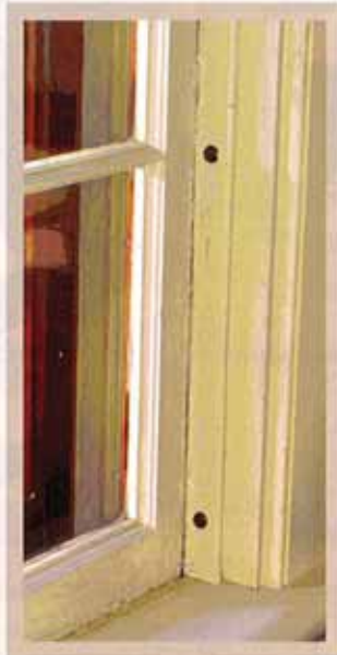
Figure 3 Re-installing the interior stops with screws and grommets makes future removal easier. / Réinstaller les moulures intérieures en les vissant et en posant des œillets pour faciliter l'enlèvement à l'avenir.
